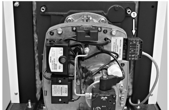
Abb. 12: Montage des Euro-Anschluss-Steckers ①
