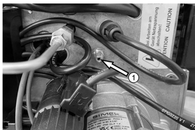
Abb. 27: Messnippel ① zur Prüfung der Gebläsepression
