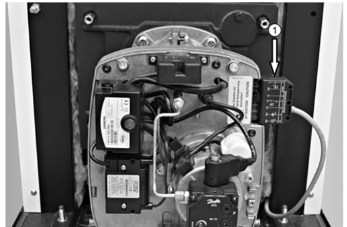
Abb. 12: Montage des Euro-Anschluss-Steckers ①
